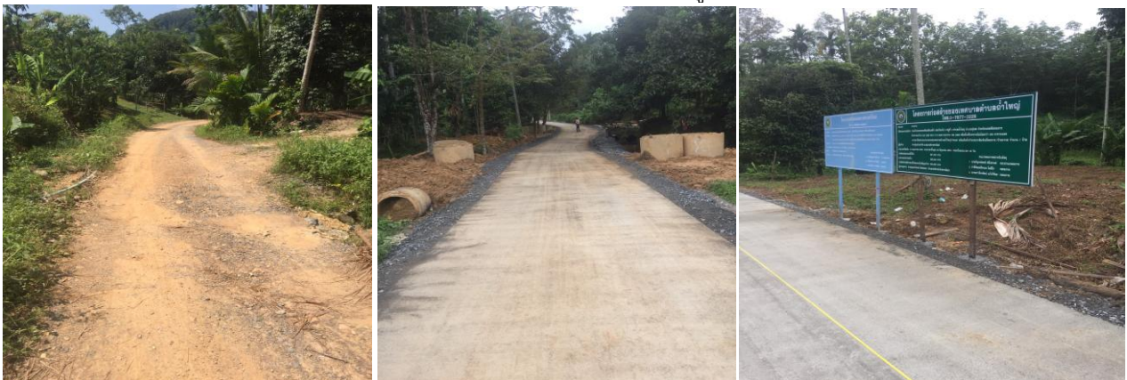
21. โครงการก่อสร้างถนนคอนกรีตเสริมเหล็กสายวังแห้ง 2 หมู่ที่ 9 งบประมาณ 694,980 บาท
