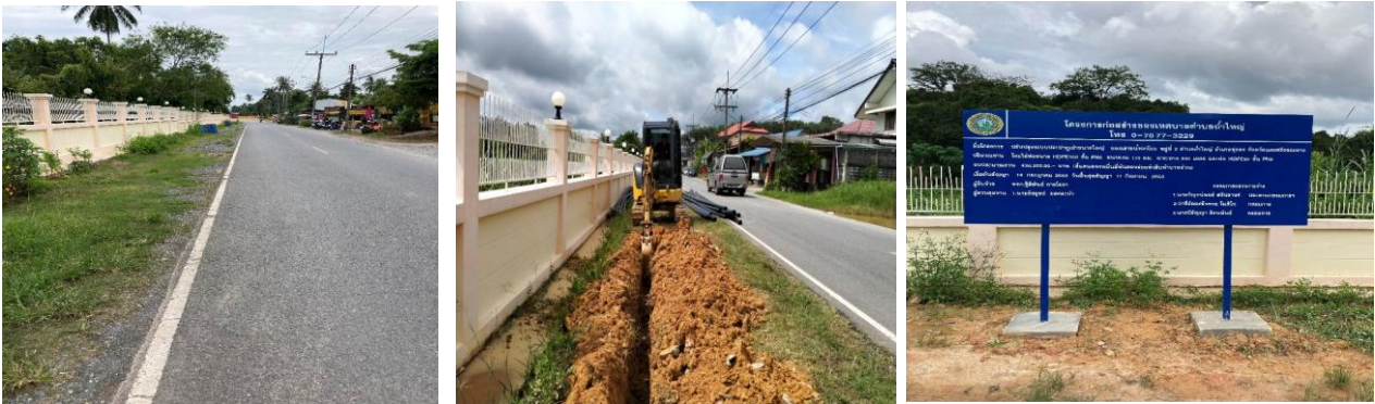
31. โครงการการปรับปรุงซ่อมแซมระบบบำบัดน้ำหมู่บ้าน แบบผิวดินขนาดใหญ่ หมู่ที่ 4 บ้านสวนทุเรียน งบประมาณ 555,555 บาท
