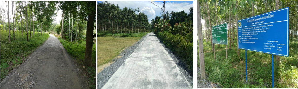
24. โครงการก่อสร้างถนนคอนกรีตเสริมเหล็กสายห้วยเล้าหมู หมู่ที่ 2 งบประมาณ 290,000 บาท
