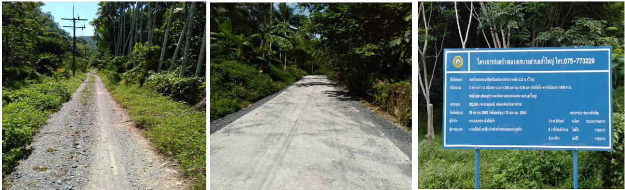
23. โครงการก่อสร้างถนนคอนกรีตเสริมเหล็กสายบ้านลุงพร้อมหมู่ที่ 8 งบประมาณ 601,000 บาท
