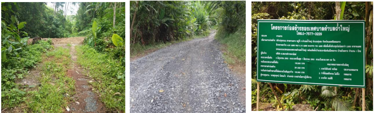
33. โครงการก่อสร้างถนนคอนกรีตเสริมเหล็กสายบ้านผู้ใหญ่สาวท - เขตเทศบาลตำบลชะมาย หมู่ที่ 10 งบประมาณ 5,858,000 บาท
