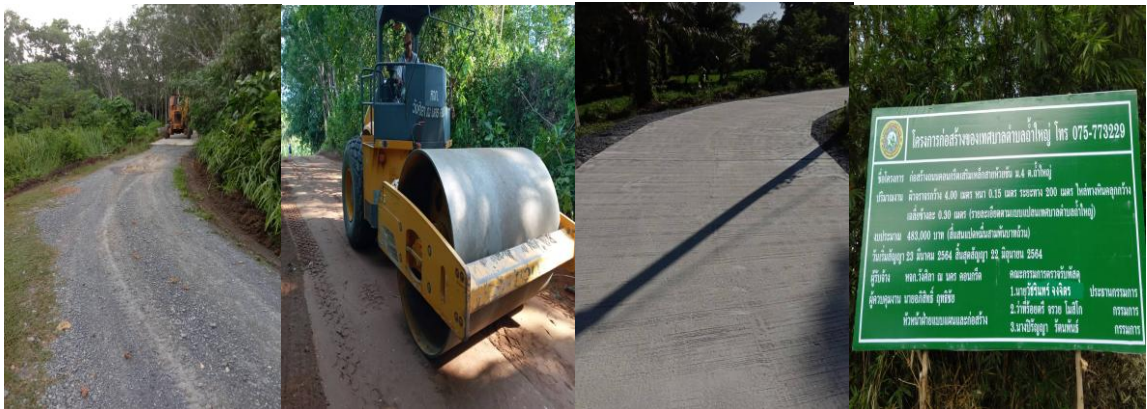
16. โครงการก่อสร้างท่อลอดเหลี่ยมสายวังปลิง หมู่ที่ 1 งบประมาณ 418,000 บาท
